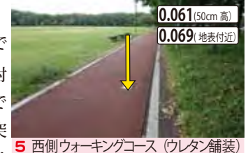
5 西側ウォーキングコース（ウレタン舗装）
